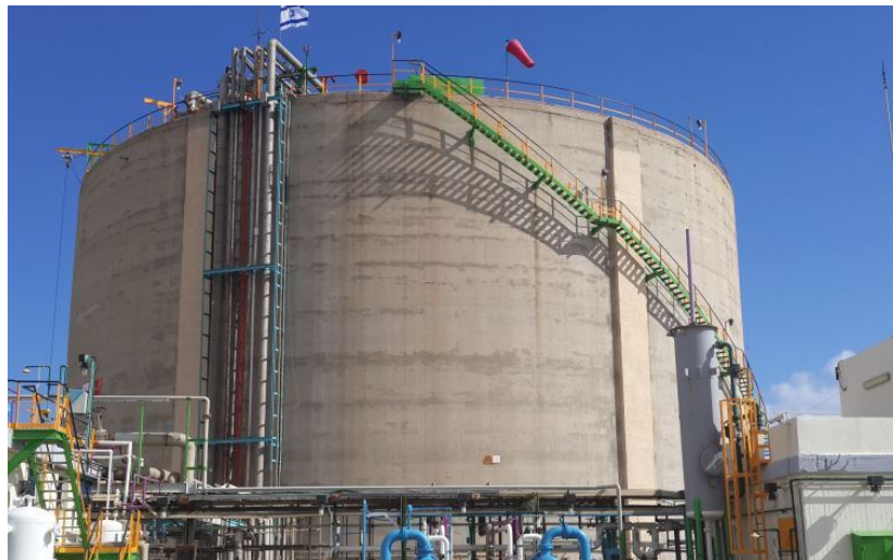
איור 1 - מיכל האמוניה הנבדק
