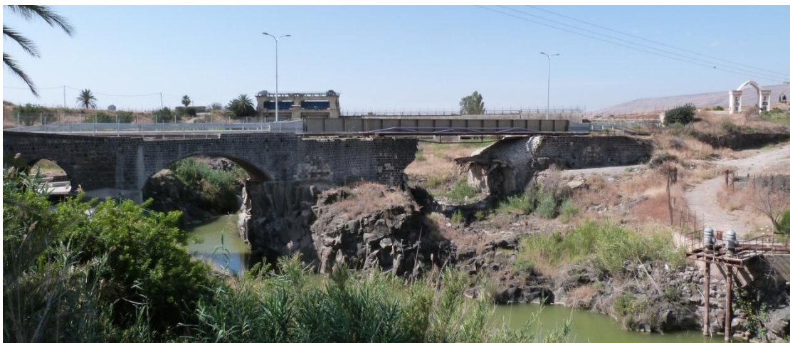
הגשר החדש במקומו ע"ג גשר הקשתות ההיסטורי
